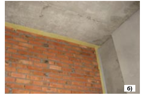
Рис. 4. Устройство изоляции структурного шума для кирпичной перегородки: а) перегородка установлена на упругую прокладку Sylomer L25; б) в стыках перегородки с перекрытием и внешней стеной применена прокладка «Вибростек»
