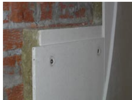
Рис. 7. Панельная система ЗИПС-Модуль, смонтированная на кирпичной стене
