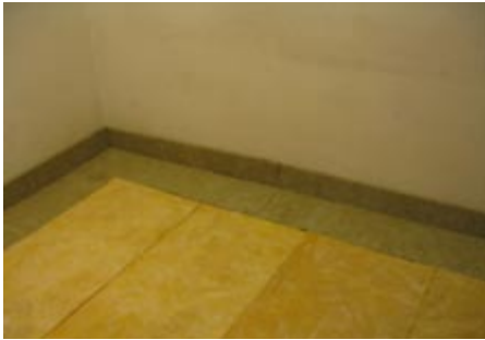
Рис. 3. Раскладка плит «Шумостоп-С2» и «Шумостоп-К2» перед устройством стяжки «плавающего» пола
