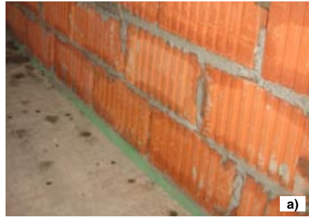
Рис. 4. Устройство изоляции структурного шума для кирпичной перегородки: а) перегородка установлена на упругую прокладку Sylomer L25; б) в стыках перегородки с перекрытием и внешней стеной применена прокладка «Вибростек»
