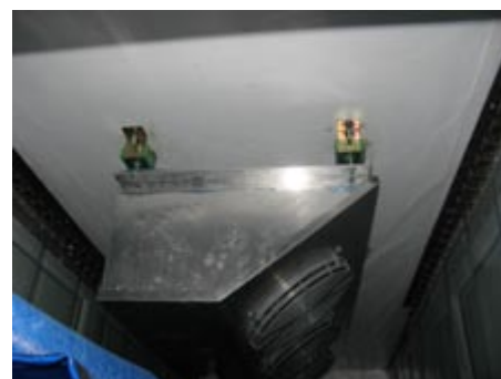
Рис. 13. Виброизоляция блока кондиционера при помощи подвесов «Виброфлекс»
