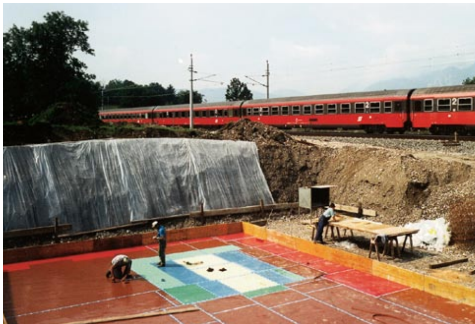
Рис. 3. Раскладка материала SYLOMER в зависимости от нагрузки на фундамент
