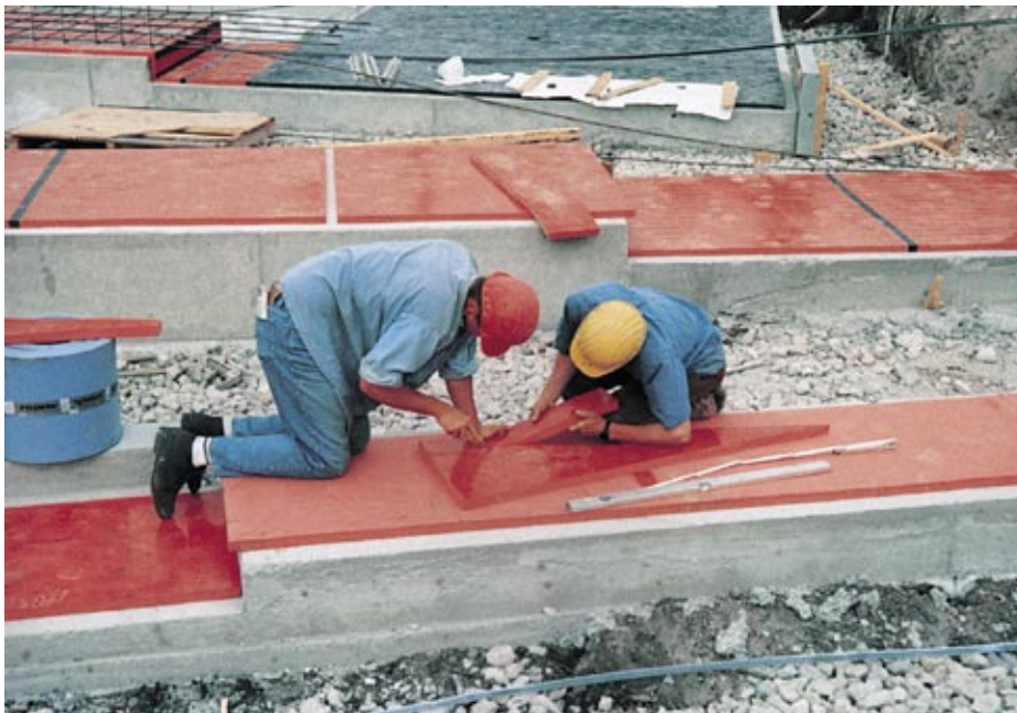
Рис. 6. Укладка ленточных опор из материала SYLOMER
