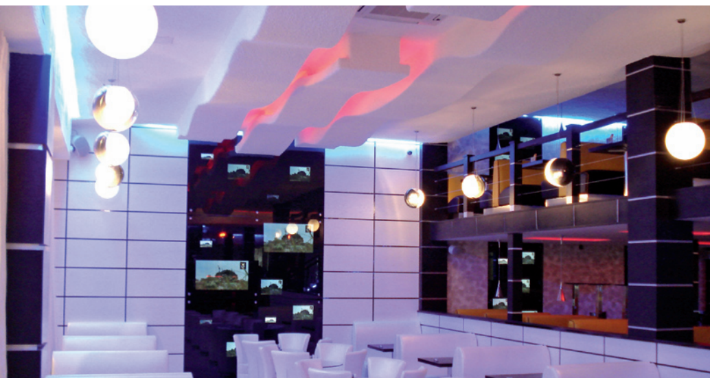
Ресторан во всесезонном горнолыжном комплексе СНЕЖКОМ. Акустическое оформление потолка помещения выполнено по технологии «SonaSpray»
